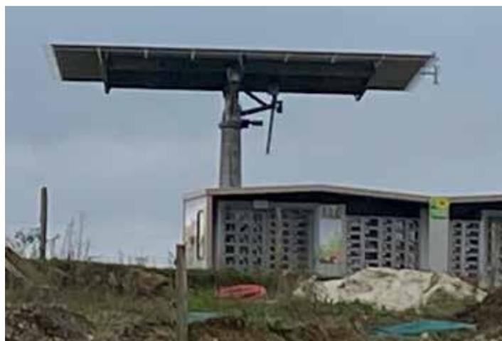
Son exploitation, un vaste poulailler, permet au vu des surfaces allouées (10 hectares pour 24 000 poules pondeuses) d'y intégrer un projet photovoltaïque. En effet, celui-ci vise à installer des panneaux sur ombrières fixes pour une puissance de 499,99 kWc(\*) et un suiveur des rayons du soleil qui augmente son rendement de 15 à 20% en moyenne pour une puissance supplémentaire de 22 kWc(\*).
